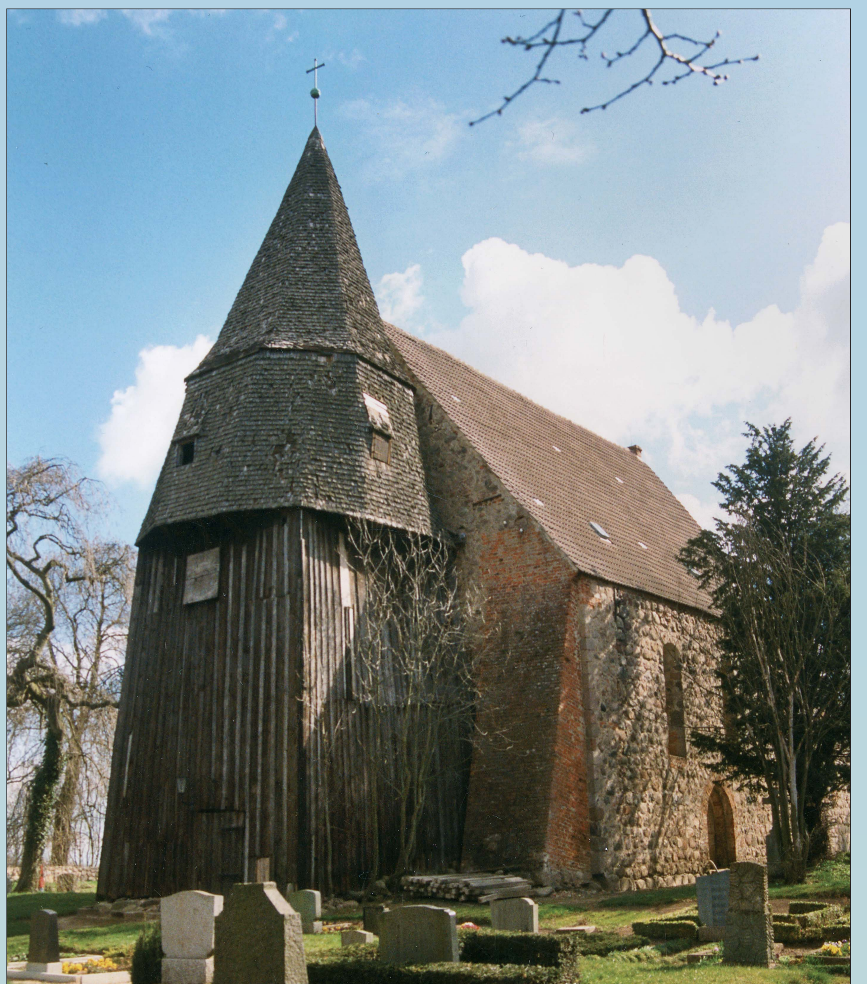
Kirche Tribohm im Jahr 1997 mit baufälligem Turm und Betondachziegeln
