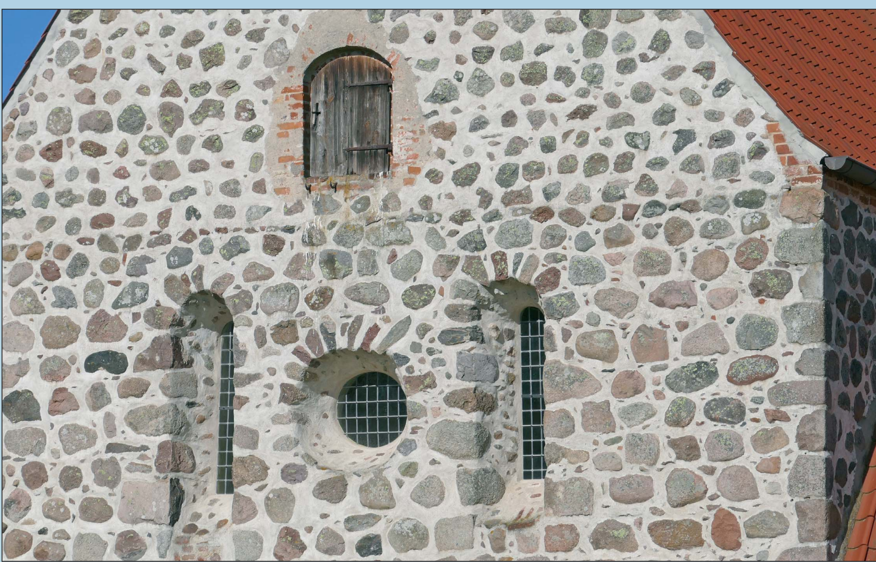
Rundfenster in der Ostwand
