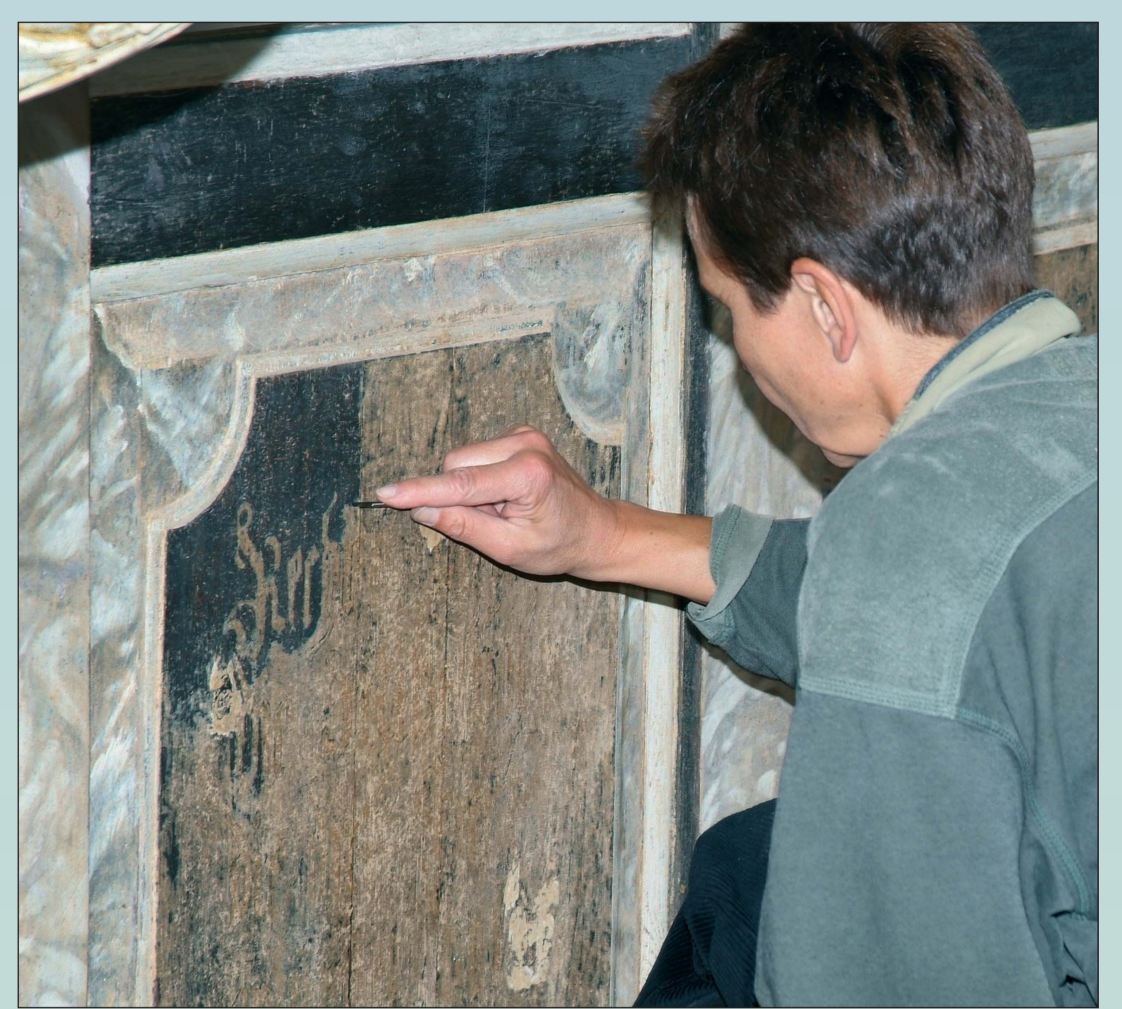
Die späteren Farbschichten auf Altar und Kanzel wurden abgetragen und die barocke Fassung freigelegt und restauriert
