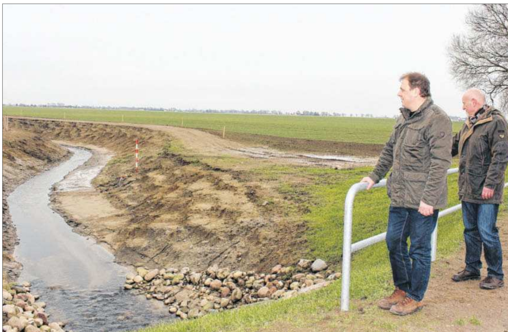
Olaf Stietzel, stellvertretender Bürgermeister von Ahrenshagen-Daskow, schaut sich gemeinsam mit Burkhard Schade vom Bürgerbüro den geöffneten Abschnitt des Templer Baches an. Auf 420 Metern wurden die Rohre entfernt. Foto: Anika Hoepken
