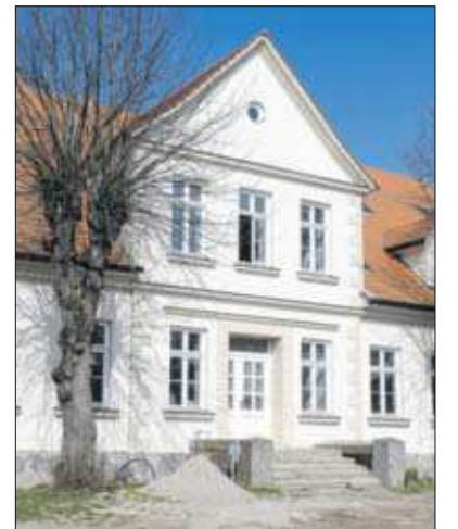
Das Gutshaus wird saniert, auch die Fassade ist neu.
