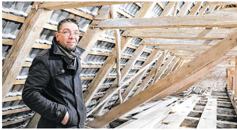
„Die Dachziegel sind für den Dachstuhl eigentlich zu schwer“, sagt Pastor Christhart Wehring.
